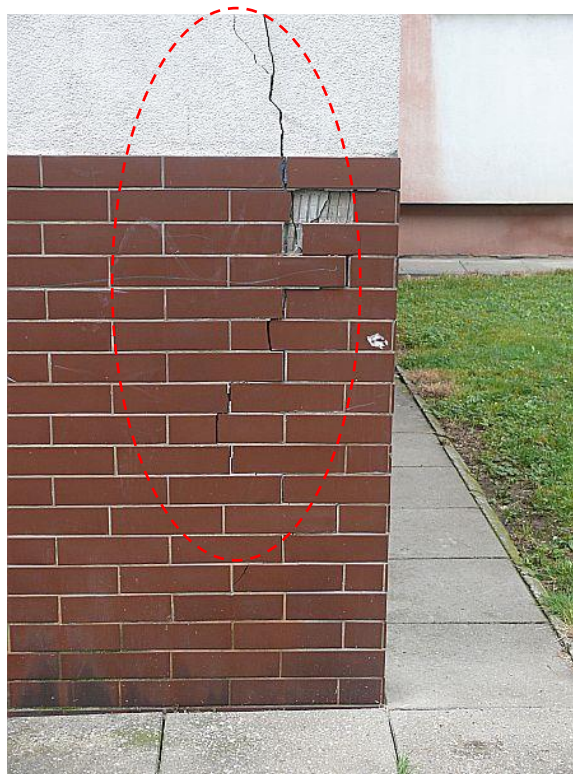
Fot. 15. Pełny widok uszkodzeń narożnika ganku budynku WSS-E. Narożnik południowo – wschodni. Widoczne ubytki okładziny ceramicznej oraz zasięg i charakter zarysowania wskazujący na rozdzielanie murów.
