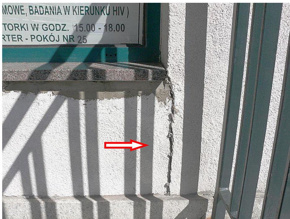
Fot. 24. Odspojenie z przemieszczeniem słupka ganku od muru podokiennego na opartego na posadzce części niepodpiwniczonej ganku budynku WSS-E. Przemieszczenie 10 mm
