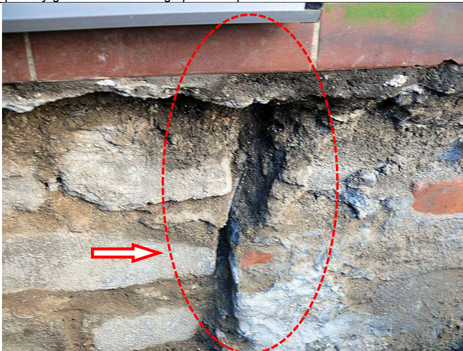
Fot. 6. Odkrywka styku murów ganku budynku WSS-E. Brak przewiązania murów. Szczelina do 50 mm. Cofnięcie muru z elementów betonowych poza lico okładziny ceramicznej ok. 70 mm. Cofnięcie okładziny muru warstwy dociskowej papy z cegły ceramicznej pełnej poza lico okładziny ceramicznej ok. 30 mm. Stan na dzień : 29.08.2017 r.
