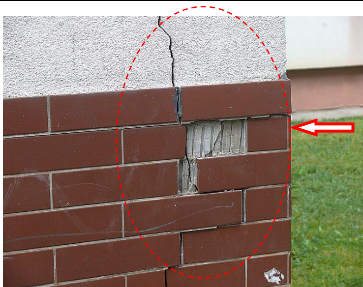
Fot. 16. Zbliżenie uszkodzeń narożnika w tym odpadanie płytek ceramicznych.
