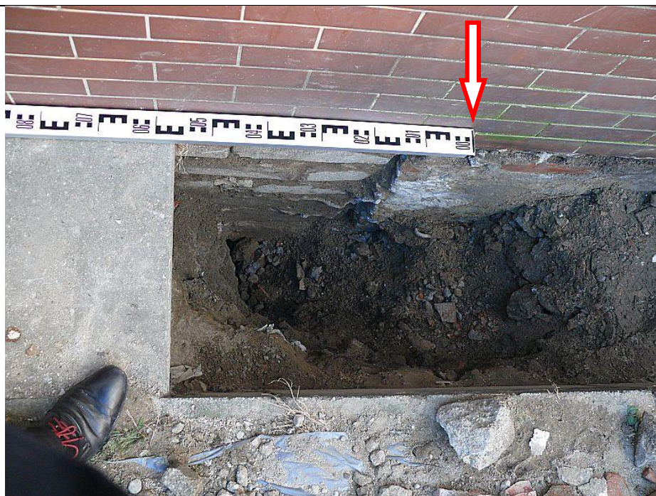
Fot. 5. Odkrywka styku murów ganku budynku WSS-E w części podpiwniczonej i niepodpiwniczonej. Widać mur z elementów betonowych dla części niepodpiwniczonej i mur ceglany ścianki dociskowej izolacji papowej piwnicy ganku. Brak równego poziomu posadowienia. Stan na dzień : 29.08.2017 r.
