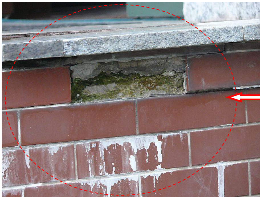
Fot. 18. Zbliżenie ubytków i przemieszczeń oraz wypływu soli z elementów elewacji, murów i posadzki ganku przy wejściu do budynku WSS-E.
