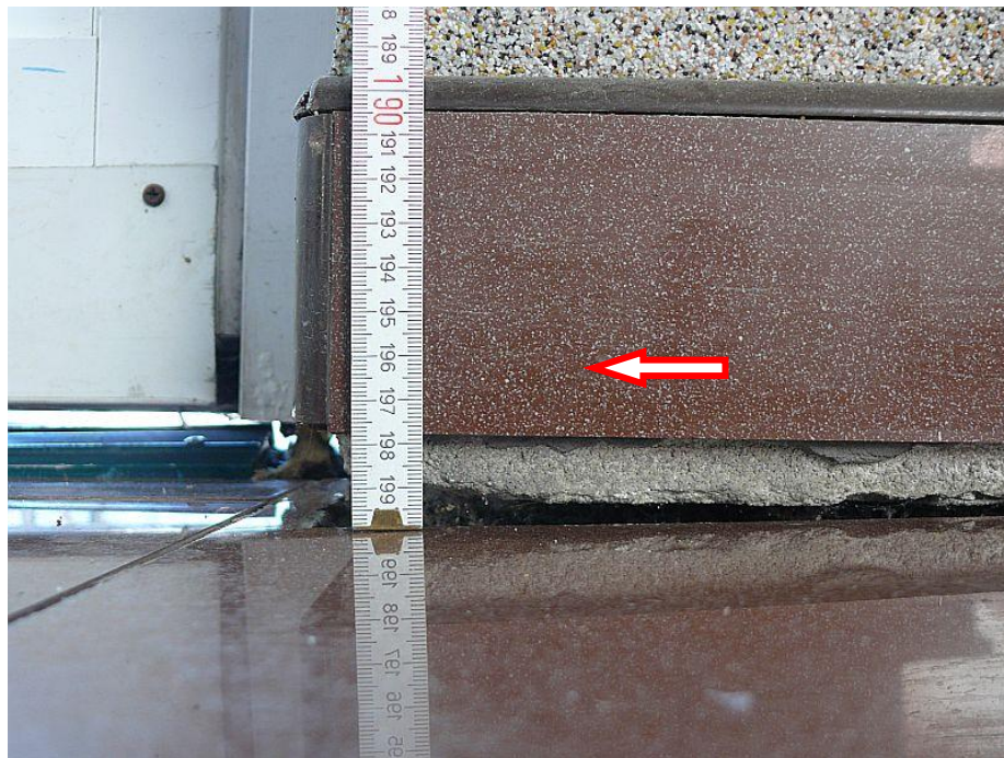
Fot. 21. Osiadanie posadzki części niepodpiwniczonej ganku od wewnątrz pomieszczenia. Wielkość osiadania 22 mm !!! Osiadanie uwidoczniło także w 2013r. – fot. 20 Stan na dzień : 29.08.2017 r.
