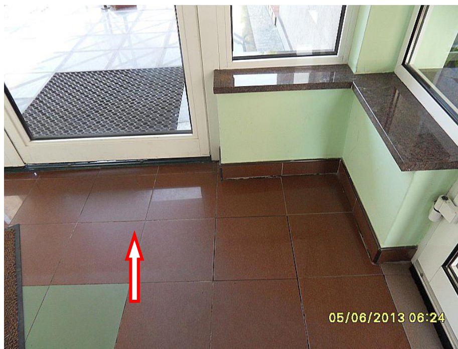
Fot. 20. Osiadanie posadzki ganku przy drzwiach wejściowych do budynku na części niepodpiwniczonej ganku. Widać podniesione drzwi oraz obniżoną posadzkę. Stan na dzień : 05.06.2013 r.
