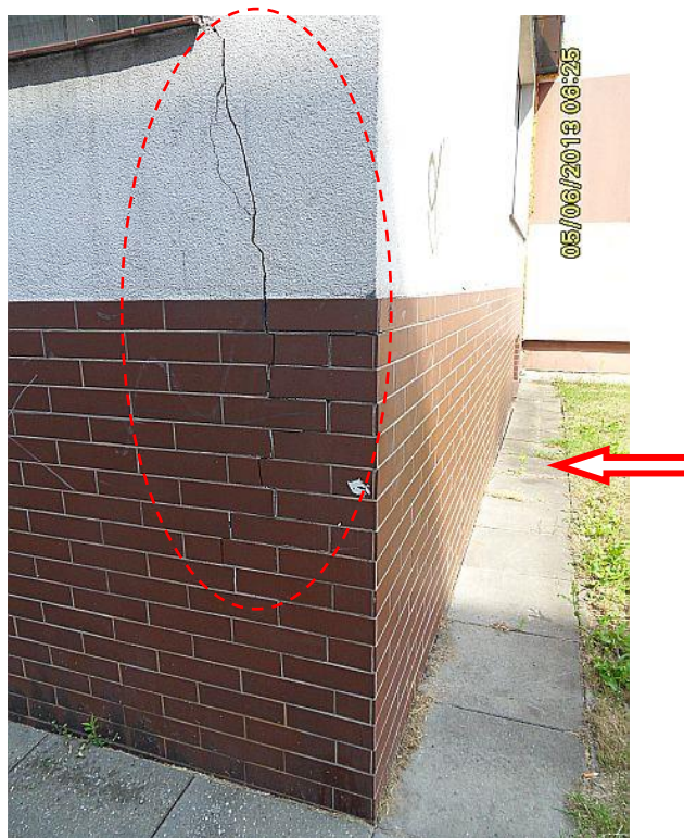
Fot. 13. Uszkodzenia murów i elewacji ganka budynku WSS-E. Narożnik południowo – wschodni. Widoczny brak ubytków okładziny ceramicznej. Stan na dzień : 05.06.2013 r.
