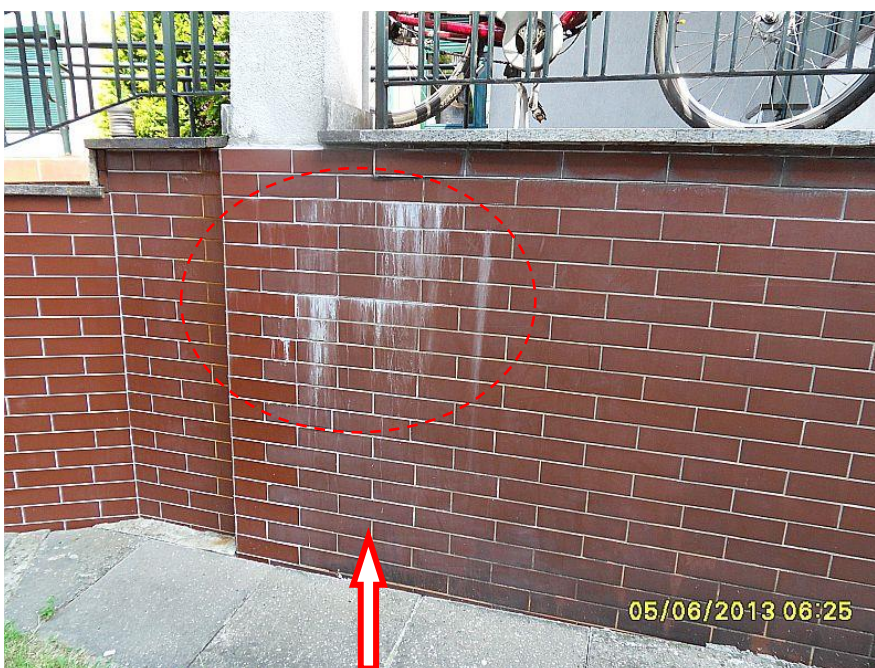
Fot. 12. Uszkodzenia elewacji południowej w czasie przeglądu budynku w 2013r. Stan na dzień : 05.06.2013 r.
