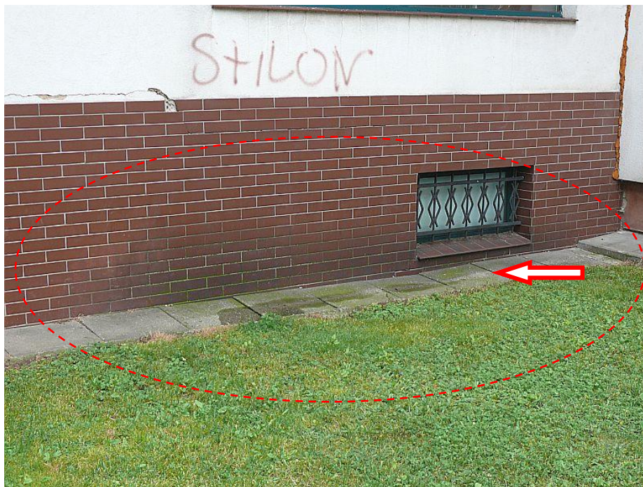
Fot. 19. Ślady działania wilgoci od rozprysków wody na elewacji zachodniej ganku. Ganek nie posiada rynien i rur spustowych! Widać obniżenie płytek chodnikowych opaski o 20 ÷ 30 mm od linii okładziny.. Stan na dzień : 11.08.2017 r.
