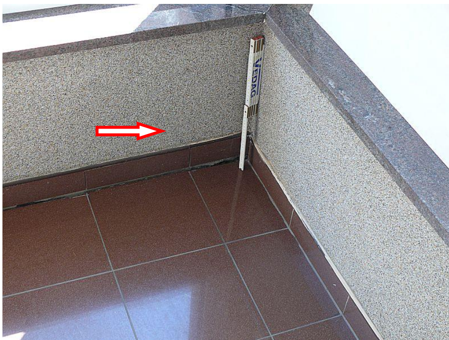
Fot. 22. Osiadanie posadzki części niepodpiwniczonej ganku wewnątrz pomieszczenia. Wielkość osiadania w narożniku ganku 20 mm. Stan na dzień : 29.08.2017 r.
