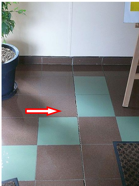
Fot. 25. Rozwarstwienie płytek posadzki w hallu budynku WSS-E na styku budynków o różnej wysokości kondygnacji. Rozwarście 5 \div 8 mm.
